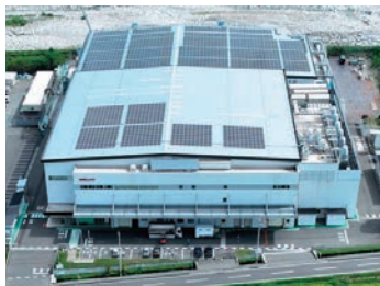
宮田工場の太陽光パネル
