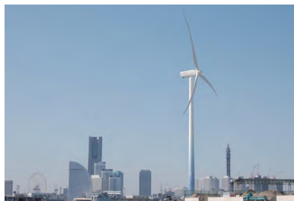
横浜市風力発電所（ハマウイング）
