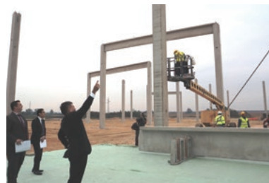
建設現場で行われた梁上式
